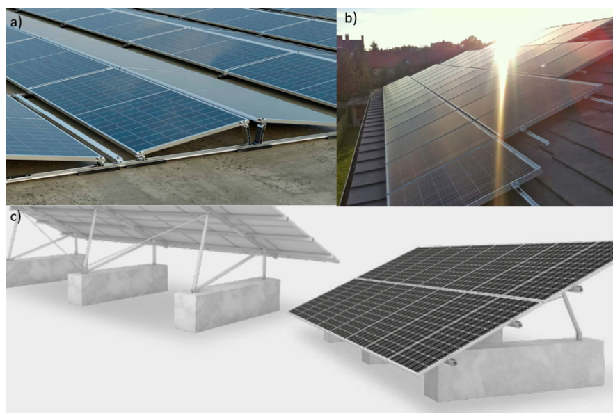
Obrázek 2.6: Typy konstrukcí pro a) ploché střechy, b) šikmé střechy, c) pozemní instalace, převzato z produktového katalogu společnosti K2 Systems
